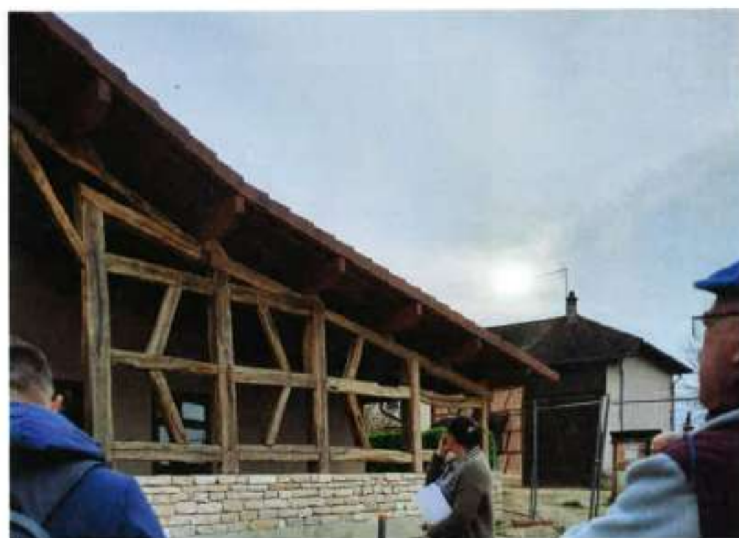
Des colombages réutilisés en applique extérieure.
